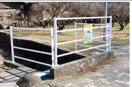
米川1区町裏北沢通学路 転落防止柵・危険注意看板設置
