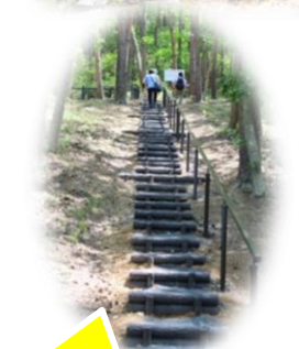
改修された切捨場 霊場への階段
