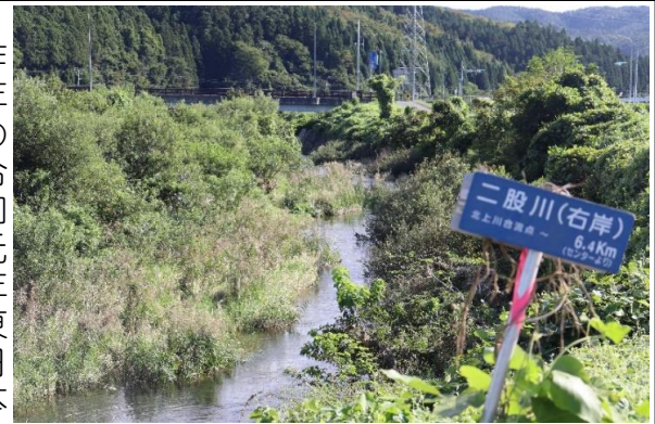
繁茂する支障木 二股川梨の木大橋付近
